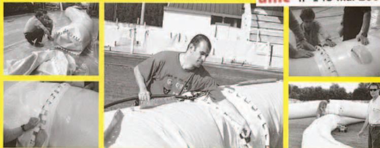
Un système de crénellation permet l'aboutement des 9 pièces gonflables. Un tube verrouille les pièces entre elles. L'ensemble se comporte comme une monopoutre.
